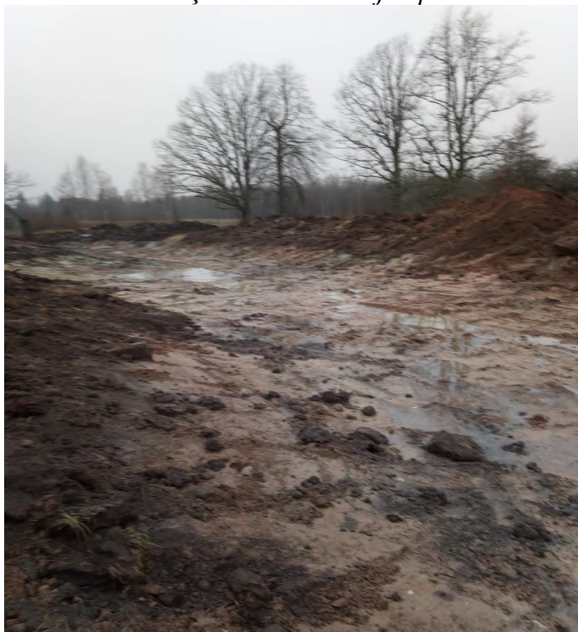
Attēls Nr. 2. Dīķis rekonstrukcijas procesā
