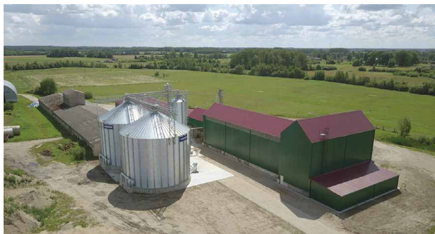
SIA “Skrīveru sēklkopības sabiedrības” graudu kalte
